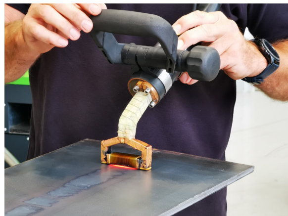
Abbildung 2: Induktives Richten eines geschweißten Doppel-T-Trägers
