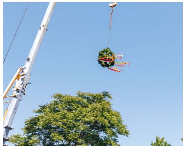
Der Richtkranz, Zeichen der Rohbaufertigstellung.
