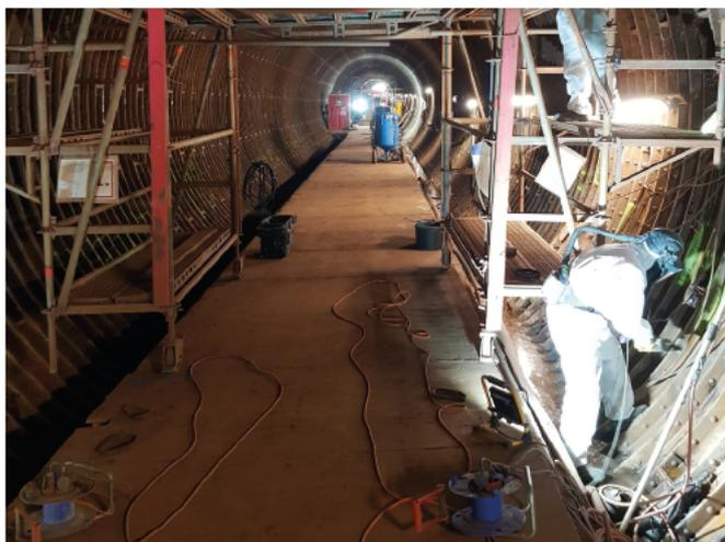
Im entkernten Rohr des Alten Elbtunnels: Durch die Bleibelastung arbeiten die Ingenieure hier mit Vollschutzanzug. (Bild: SLV Nord gGmbH)
