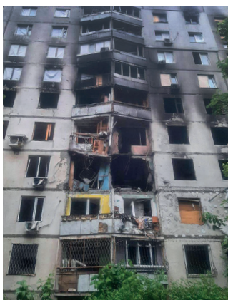
| Zerstörter Wohnblock © Dmytro Zakharov
