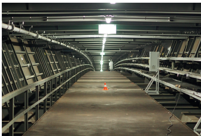
Highlight der 20. Tagung: Ein Gang durch den vibrierenden Stahlhohlkasten der Köhlbrandbrücke, © SLV Nord gGmbH
