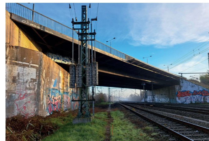
Ansicht des Gesamtbauwerkes der B1-Brücke © SLV Halle GmbH 2024
